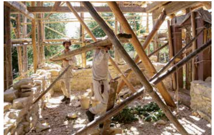
Auf dem „Campus Galli“ entsteht Tag für Tag ein Stück Mittelalter.
